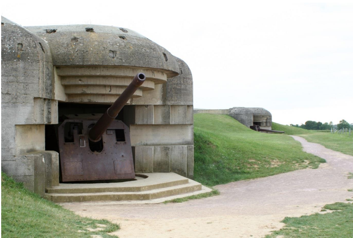
21. kép: 150 mm-es tengerészeti ágyúk Franciaország partjain páncélpajzs és betonbunker védelmében (utóbbiak Longue-sur-mernél).
