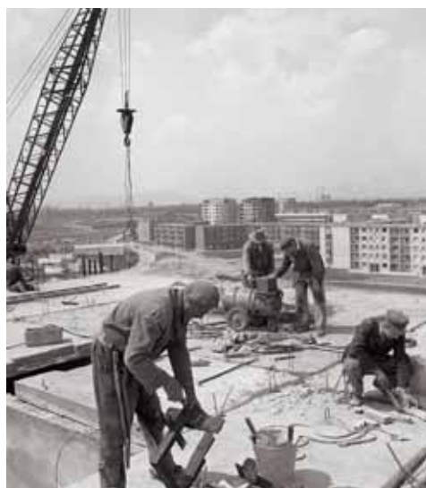
A József Attila-lakótelep építése, 1962. július. MTI Fotó: Lajos György
