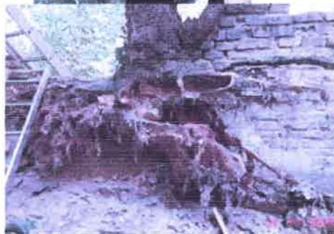
A fa gyökfő alatti ritka gyökeres része a két támfal között a kimosódott föld miatt szinte a "levegőben lóg."
