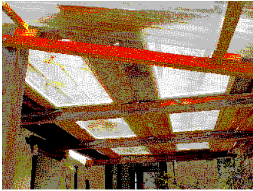
Wiederverwertung von alten Fensterflügeln: lassen Licht und Wärme durch.
