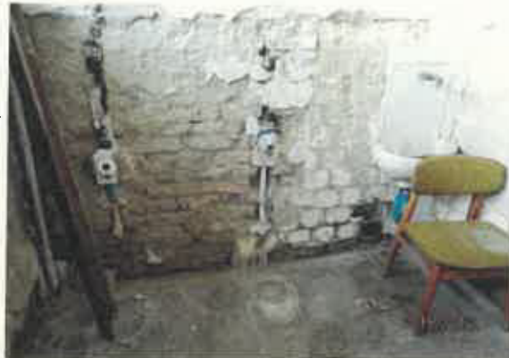
Korábbi öltöző (12.), felújítás elkezdődött, de abbamaradt
