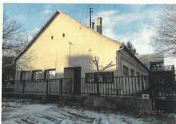
ÉK-i, utca és bejárat felőli homlokzat
