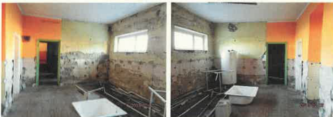
Korábbi öltöző (9.), felújítás elkezdődött, de abbamaradt
