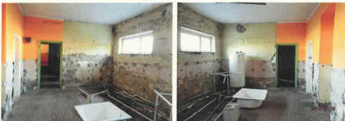
Korábbi öltöző (9.), felújítás elkezdődött, de abbamaradt
