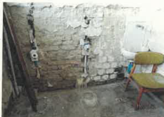
Korábbi öltöző (12.), felújítás elkezdődött, de abbamaradt
